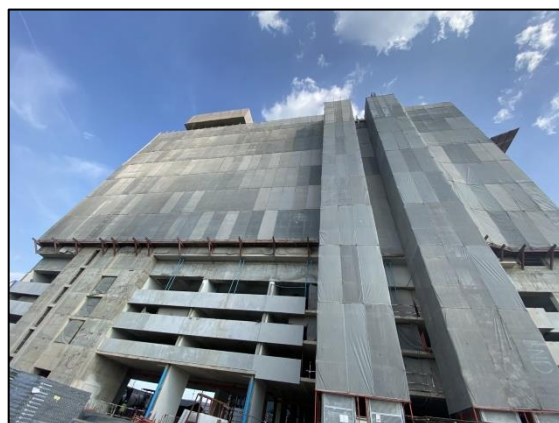
รูปที่ 2-34 Mesh Sheet
