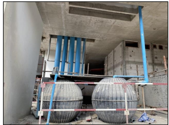
รูปที่ 2-38 ถังบำบัดน้ำเสียสำเร็จรูป
